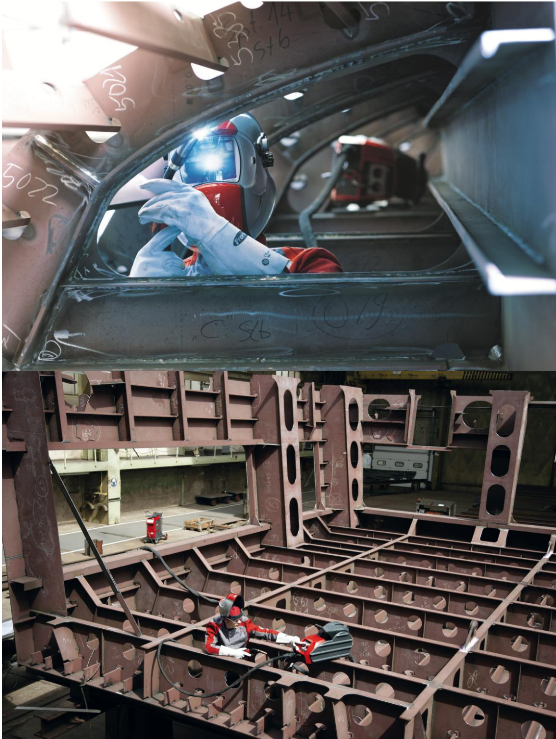
Bild 3: Die rauen Bedingungen im Stahlschweißen erfordern eine perfekte Systemperformance des Schweiß-Equipments.
