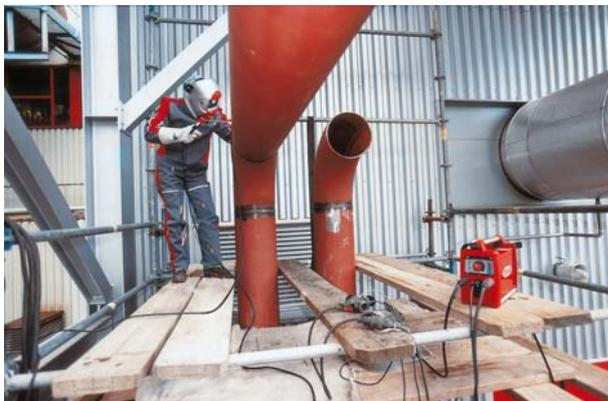
1: Das Konzept der „resonanten Intelligenz“ sorgt bei den TransPocket 2500 und 3500 für stabile Lichtbögen – auch bei großen Entfernungen – und für ideale Kennlinien.
